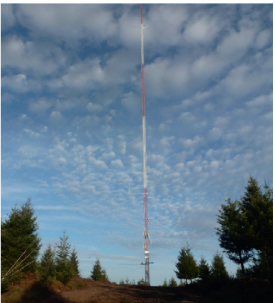
Mât 50m Les Noës - Crédit photo - UL International 2018
